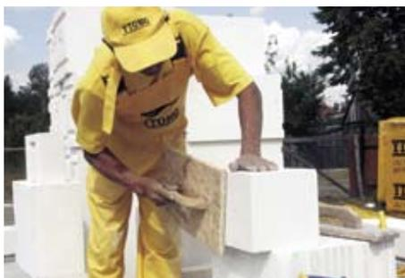
Чтобы получить гладкую поверхность распиленного блока и обеспечить хорошее прилегание раствора, поверхность блока выравниваем рубанком или полутерком.
