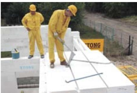
После уложения очередной панели, ее следует прижать в притык к предыдущей панели.
