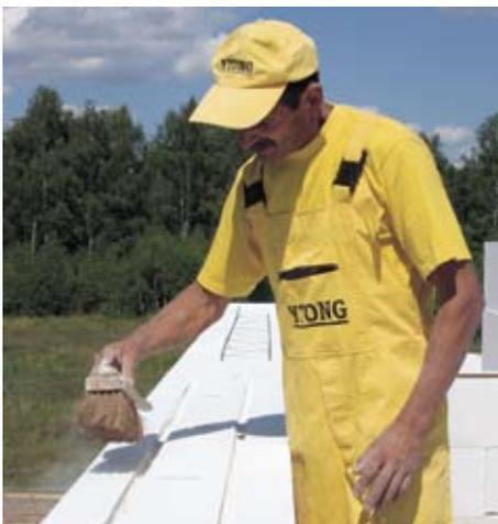
Канавки заполняем цементным раствором, а затем помещаем в них прутья. Путья следует перед этим отрезать на необходимую длину.
