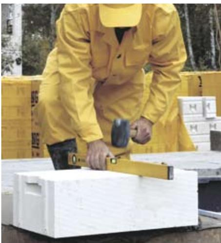
После установки блока YTONG проверяем его уровень и поправляем при помощи резинового молотка.
