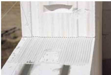
Перед приступлением к кладке очередного ряда, следует осушить поверхность блоков, например, при помощи щетки. Благодаря этому, мы получим гладкую поверхность блоков и раствор будет лучше прилегать.
