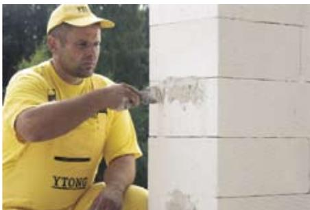
Раствором мы также можем заполнить монтажные. Избыток раствора удаляем после его отверждения при помощи куска блока YTONG.
