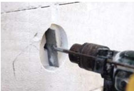
Отверстия под монтажные коробки сверлим при помощи специальной плоской ножовки.
