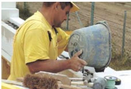
Использование U-образных перемычек YTONG, как опалубку, позволяет выполнение перекрытий с большой нагрузкой.
