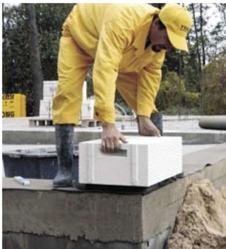
Кладку наружных стен начинаем с углов. Стоит обратить внимание на кладку блока так, чтобы шпунты были направлены наружу – это облегчит позднейшие отделочные работы. Будет легче со шлифовать шпунты, чем наполнять их штукатуркой.
