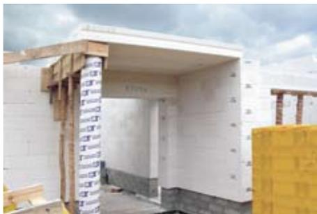
Только в системе YTONG, потолочные панели можно выдвигать за пределы контура здания, получая, таким образом, балкон. Максимальное выдвигание крепящей панели за пределы стены составляет 1,5 м.
