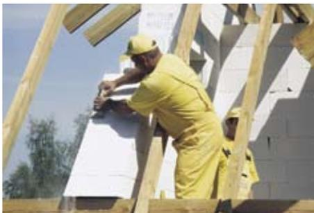
Вместо изнурительного пополнения стены мелкими элементами (наприм. кирпичем), мы легко отшлифуем блоки YTONG до необходимого угла наклона стены.
