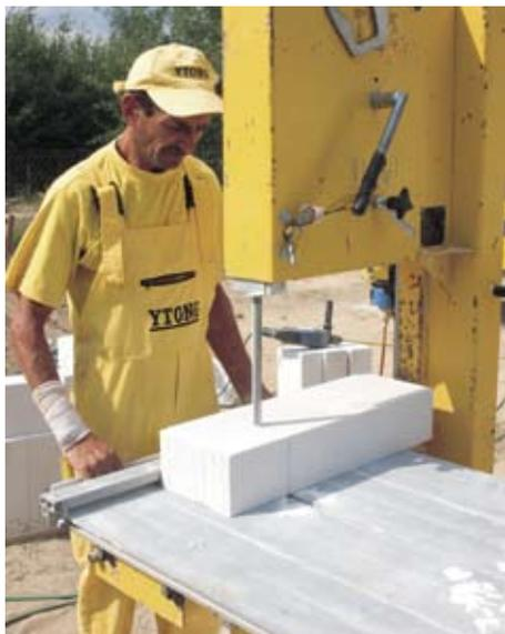
Использование для распилки электрической ленточной пилы, гарантирует высокую точность подрезки блоков требуемых размеров. Ленточную пилу стоит использовать на больших стройках – это намного ускоряет работу.
