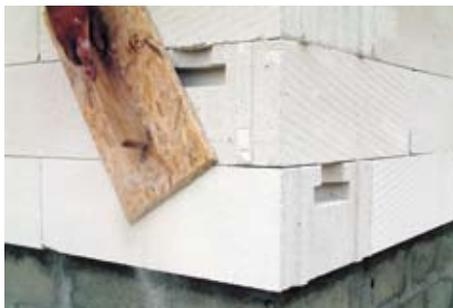
Очередные ряды наружных углов кладем попеременно, используя перевязку, при сохранении одинакового уровня очередных рядов на всех наружных углах.
