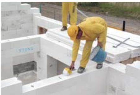
На поверхности стены, там, где будут уложены панели, следует наносить раствор YTONG. Поверхность стены в этом месте должна быть ровная и гладкая.
