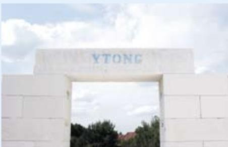
Во время монтажа готовых балок перемычек YTONG следует обращать внимание, на правильную их укладку – надпись YTONG на балке не должна быть перевернута.
