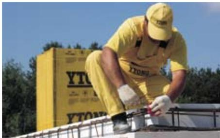
Элементы утепления венца YTONG кладем на стене на растворе для тонких швов, слоем минеральной шерсти внутрь здания.
