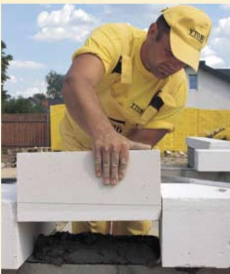
В местах, где блоки не соединяются системой шпунт-паз, например, где кладем подрезанный блок, следует выполнить вертикальный шов.
