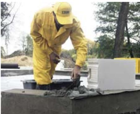
Блоки первого ряда кладем на цементном растворе, в котором отношение цемента и песка составляет 1:3. Задание обычного раствора служит для сглаживания случайных отклонений фундаментов по вертикали. Раствор наносится обычным мастерком.
