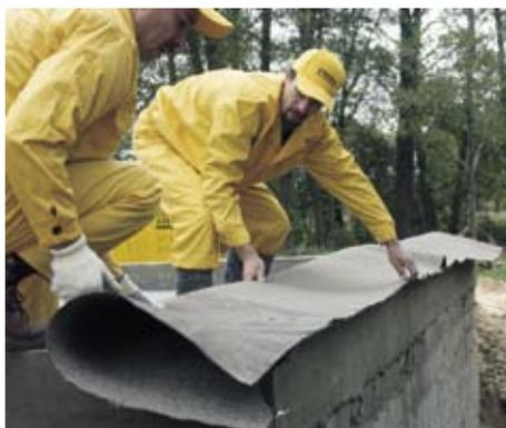
Перед тем, как приступим к кладке стены, следует выполнить в фундаменте гидроизоляцию, например, из рубероида. Благодаря этому, обеспечиваем стенам защиту от влаги.
