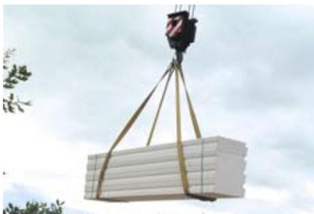
Для разгрузки панелей следует пользоваться монтажными ремнями или специальными держателями т.е. монтажными подвесками. Очень важно, чтобы панели транспортировать в горизонтальном положении.
