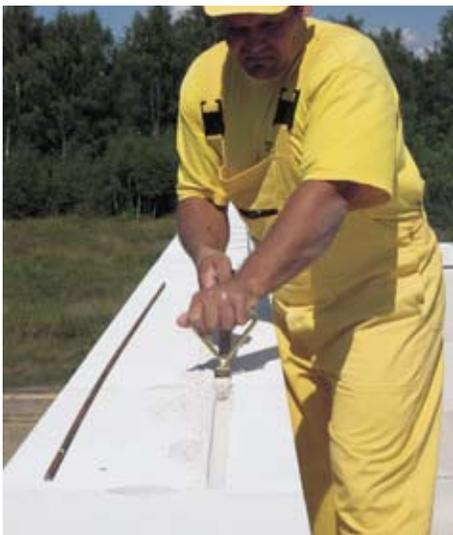
В случае использования прутьев из ребристой стали, в ряду блоков следует выполнить резцом канавки, соответствующие длине прута.
