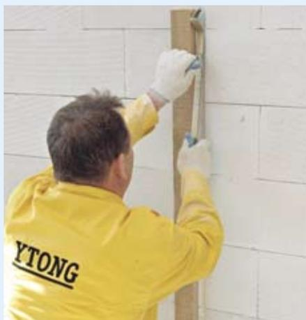
Для облегчения работы и получения прямой линии к стене следует прибить доску и вести вдоль нее резец. Тогда канавки будут идеально ровные.
