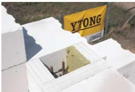
Внутри столбов кладем песок тепловой изоляции, защищающей от замерзания и препятствующей выходу тепла наружу.
