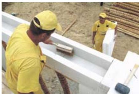
Так подготовленную внутреннюю часть опалубка следует очистить и перед бетонированием смочить водой.
