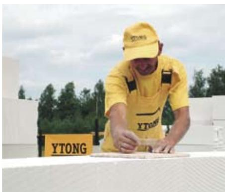
После выполнения каждого ряда блоков YTONG следует шлифовать их верхнюю поверхность. Для этого используем полутерок или рубанок, а мелкие загрязнения и получаемую пыль удаляем щеткой. Благодаря этому раствор будет иметь лучшее сцепление с блоками.
