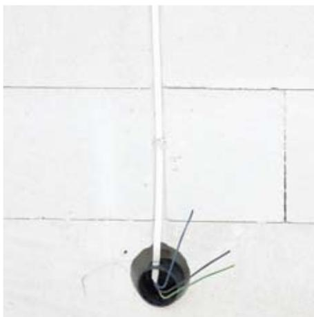
В канавках гвоздями прибиваем держатели для проводов. Затем прокладываем кабель и крепим его в держателях. В подготовленные ранее отверстия следует вложить монтажные коробки.
