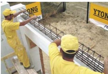
Потом укладываем в них арматуру и все заливаем бетоном.
