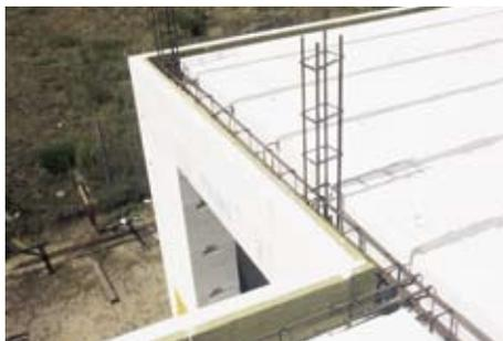
Несущие элементы здания такие, как, например, столбы для мауэрлата следует облицевать U-образными фигурными деталями YTONG, установленными вертикально. Это нам позволит правильно выполнить изоляцию железобетонных элементов и получить однородную поверхность стены.
