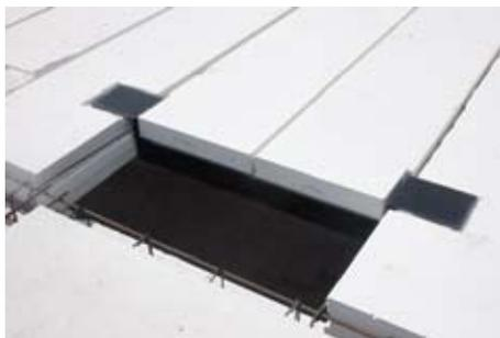
Отверстия в перекрытии, напр. для дымовых проходов (дымоходов), вентиляционных стояков, предусмотрены на этапе проекта
