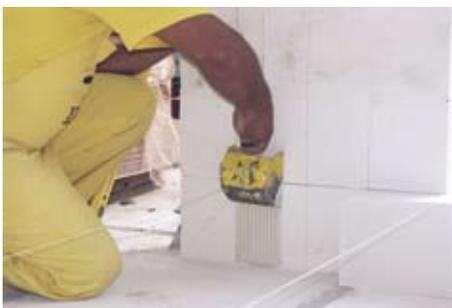
Начинаем кладку от определения линии прохождения стены. Затем уравниваем нижний ряд.
