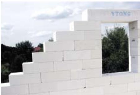
Кладка торцовой стены из блоков YTONG очень быстрая и легкая. Позднейшая шлифовка поверхности позволяет получить одинаковый наклон боков торцовой стены и конструкции крыши. Исключает также потерю тепла в этом месте.
