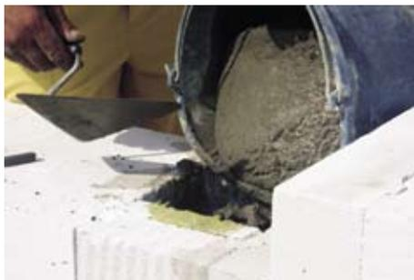
Приготовленную таким образом „опалубку” заполняем раствором, создавая крепкий железобетонный столб.
