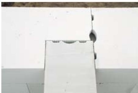
Блоки наружной стены, подрезанные соответствующим образом, позволяют вводить блоки внутренней стены на требуемую глубину.
