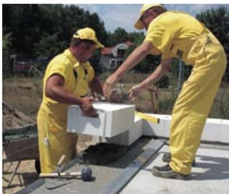
Затем, между установленными наружными углами стены следует растянуть причалку и заполнить ряд. Растянутая причалка облегчает нам контроль горизонтальной кладки блоков YTONG в ряду.
