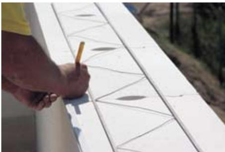
Фирменная арматура изготовлена из нержавеющей стали с малым сечением и ее можно помещать непосредственно в тонкий слой шва. С этой целью на поверхности блоков раскладываем тонкий слой и погружаем в него арматуру.
