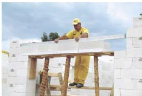
На подготовленном таким образом помосте U – образные фигурные перемычки YTONG кладутся впритык, а вертикальные швы между ними наполняются тонким слоем строительного раствора YTONG.
