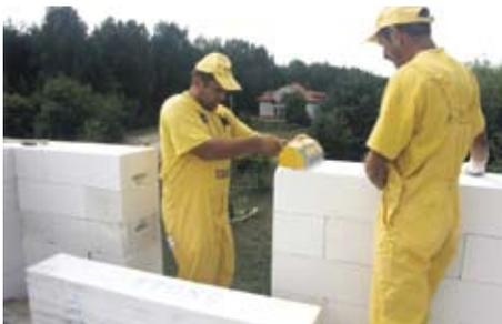
Монтаж перемычек YTONG – быстрый, занимает двум работникам несколько минут. Использование готовой перемычки гарантирует гладкую и ровную поверхность стены, что облегчает штукатурку.
