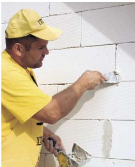
Убыли мы можем заполнить раствором, который получается после смеси раствора для тонких швов с пылью после резки блоков YTONG или специальным раствором, предназначенным для этой цели.
